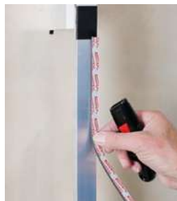
Paso 3: Colocar la cinta Foam Tape
