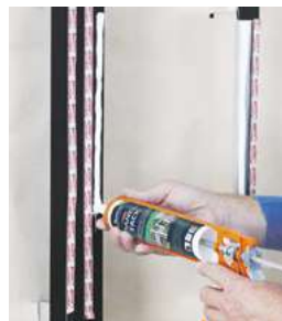
Paso 4: Aplicar el adhesivo
