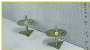
1º Posicionar niveladores.
