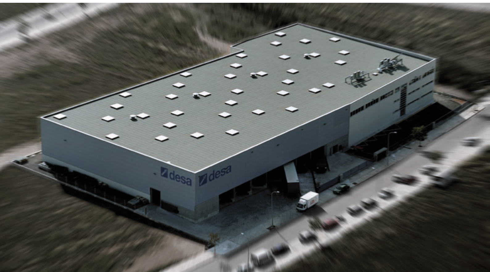
Plataforma logística de Valls, Tarragona. Plataforma logística de Valls, Tarragona.
